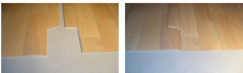
Découpe d'ouvertures au joint pour l'alignement des motifs
