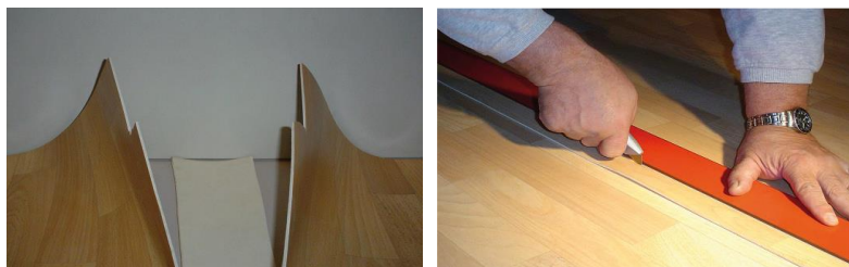
Retaille de couvre-plancher placée sous le joint - coupe en double avec une règle de précision
