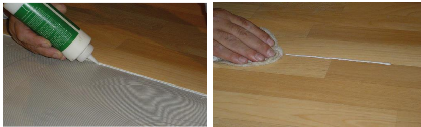
Application de scellant à joint Beauflor 262 et nettoyage avec un chiffon humide
